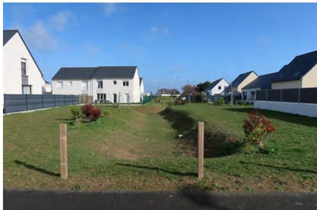
À Kerostin, une noue destinée à retenir et à infiltrer les eaux pluviales.
