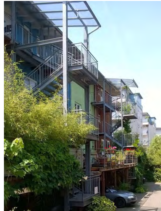
Stationnements en rez-de-chaussée d'immeuble
