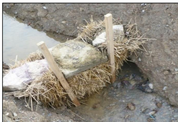
Photo 1 : Emplacement du filtre à particules fines (botte de paille) pendant la phase des travaux au niveau du bassin d'orage
