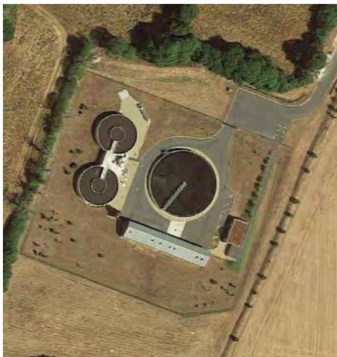
Figure 29 : station d'épuration intercommunale -Source : Orthophoto - 2016
